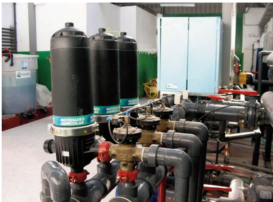
Según la naturaleza física y química del agua hay que diseñar un tratamiento específico de filtrado.
