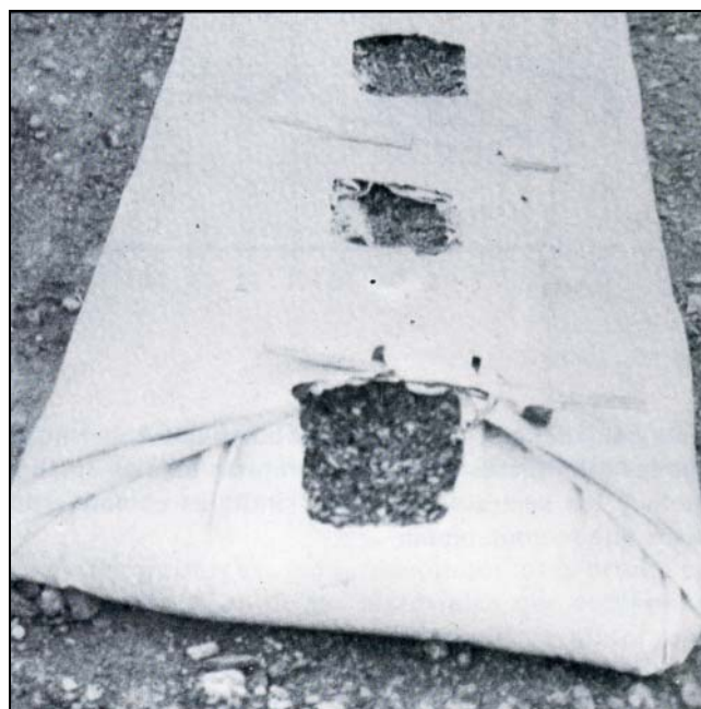
Detalle del final de una «salchicha» de arena y cerramiento con cañas. Mejores resultados.
