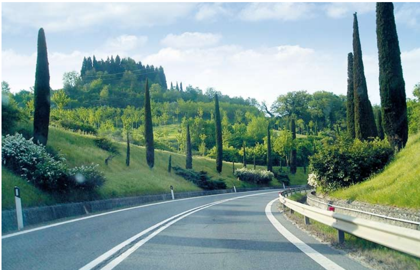
Carretera en la Toscana, Italia.
