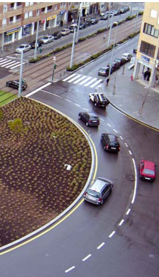
Tramo de vías de tranvía naturadas en Oporto. La naturación de superficies técnico - funcionales presenta dificultades adicionales (foto autores).
