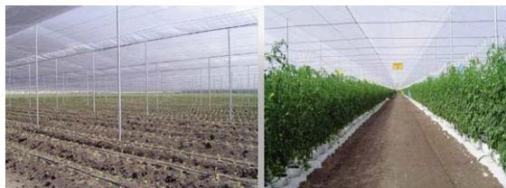
Las mallas de sombra de Invernaderos Ima disponen de un diseño de estructura modular de acero galvanizado. La cubierta de la malla está fabricada con polietileno virgen con tratamiento antisolar. La densidad del tejido es óptima para lograr una iluminación, aireación y protección adecuadas para el perfecto desarrollo de la planta.
