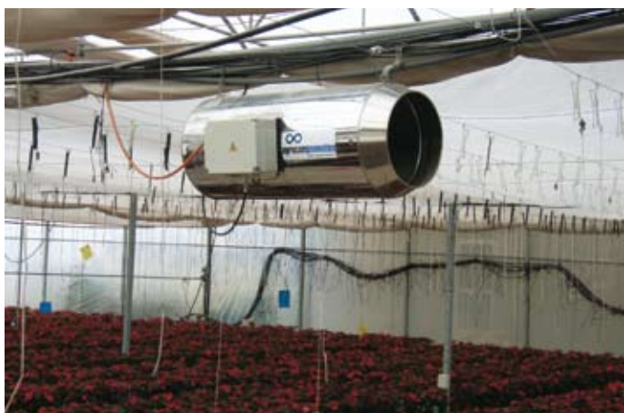
Extractores de cooling system y calefacción por gas.
