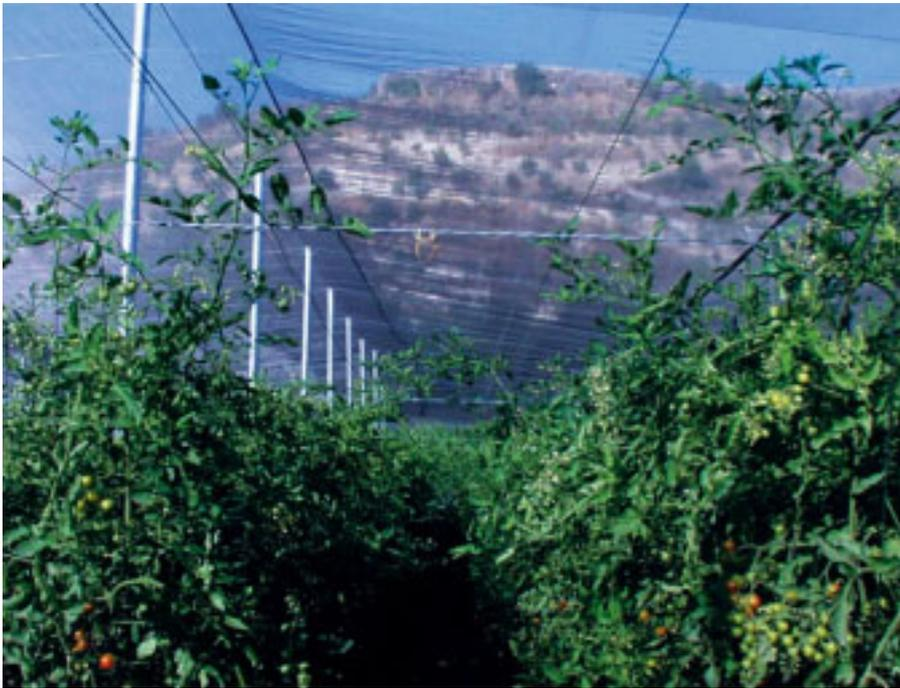
longitudinal paralelo a la cumbrera del invernadero) de entre 4,5 y 6 m. Los postes se insertan en zapatas de hormigón enterradas a medio metro de profundidad. La altura a raspa está entre 4,5 y 5 m y la altura al amagado entre 3 y 3,5 m. El diámetro de los tubos centrales suele estar en torno a los 60 mm, mientras que los tubos perimetrales tienen un tamaño superior.
