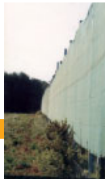
Barrera cortavientos como protección de túnel.
