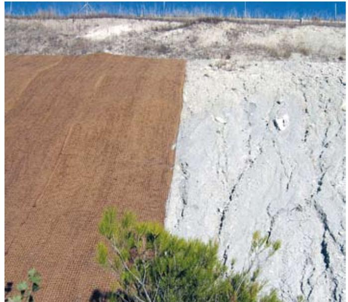
**Vista parcial del talud cubierto con K3D una vez extendido el sustrato y su diferencia respecto de la parcela sin recubrimiento de manta.**
