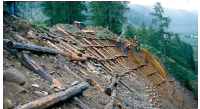
Reconstrucción de la ladera con Enrejado vivo, Alto Adige Italia
