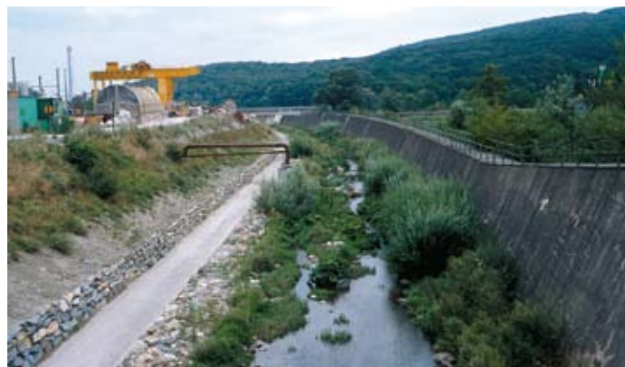
Rehabilitación del tramo anterior tras un año
