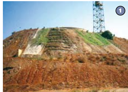
Foto 1: Talud del vertedero con intervenciones muestra
