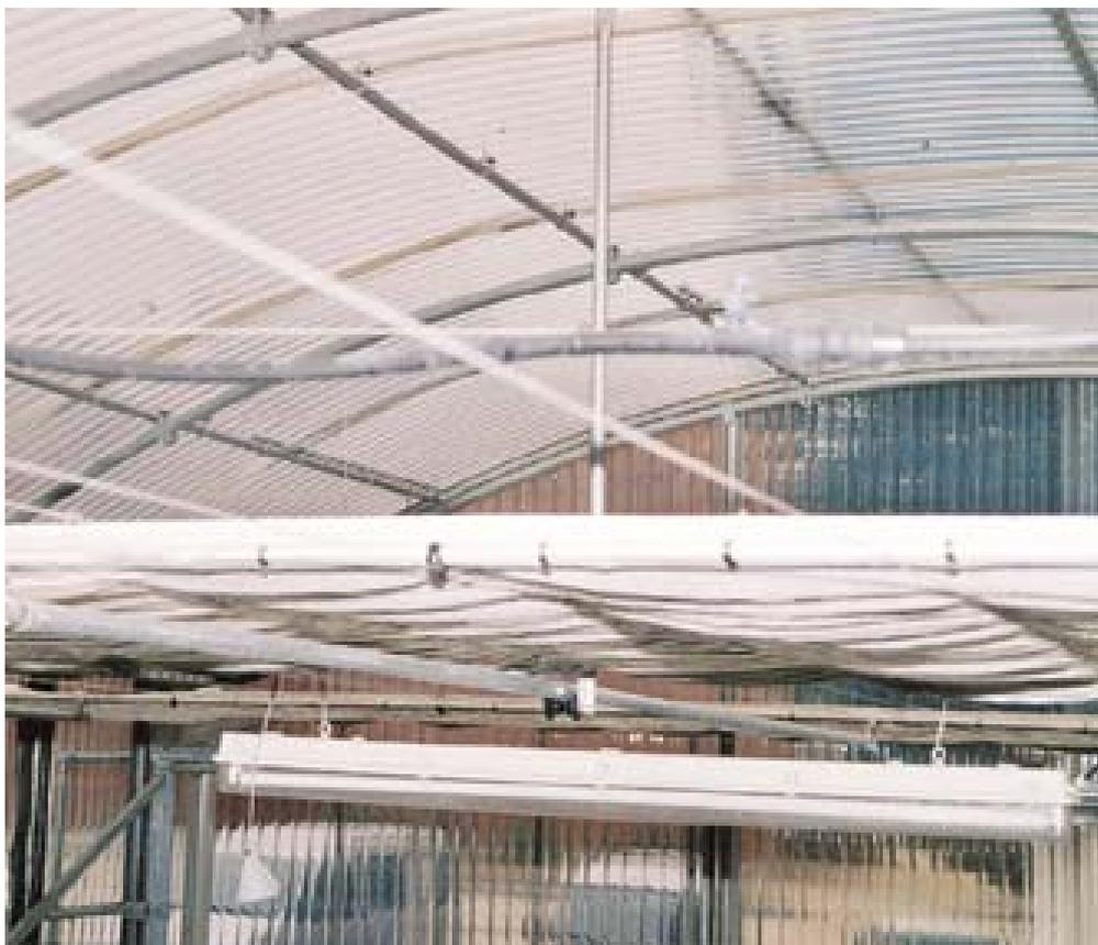
La malla de sombreado, cuyas dimensiones son de 6,6 x 20 m (5 franjas de 4 m), está colocada a la altura del canalón (3 m); es de tipo aluminizada con valores nominales del 65% de sombra y 60% de ahorro energético. El conjunto de tracción para la extensión/recogida está automatizado por medio de un motor trifásico; aunque se puede automatizar su apertura y plegado, en los experimentos se utilizó como si fuera fija.
