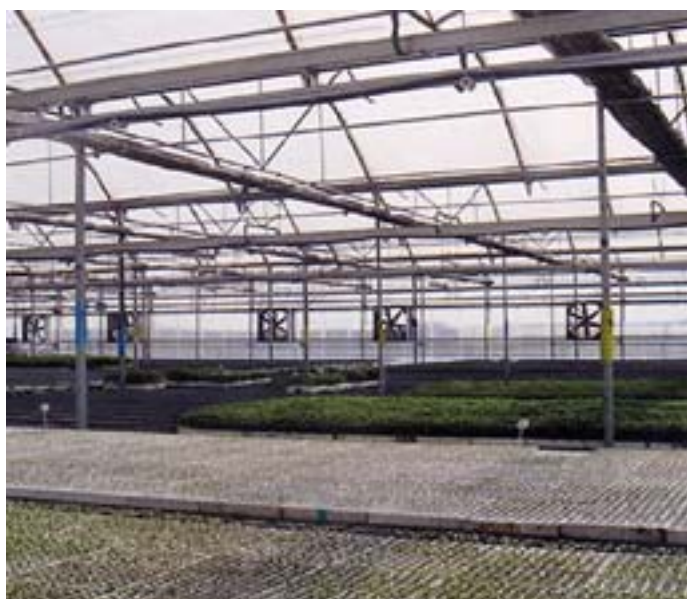
Pantallas térmicas recogidas y ventiladores en un moderno invernadero (Foto Exafan).
