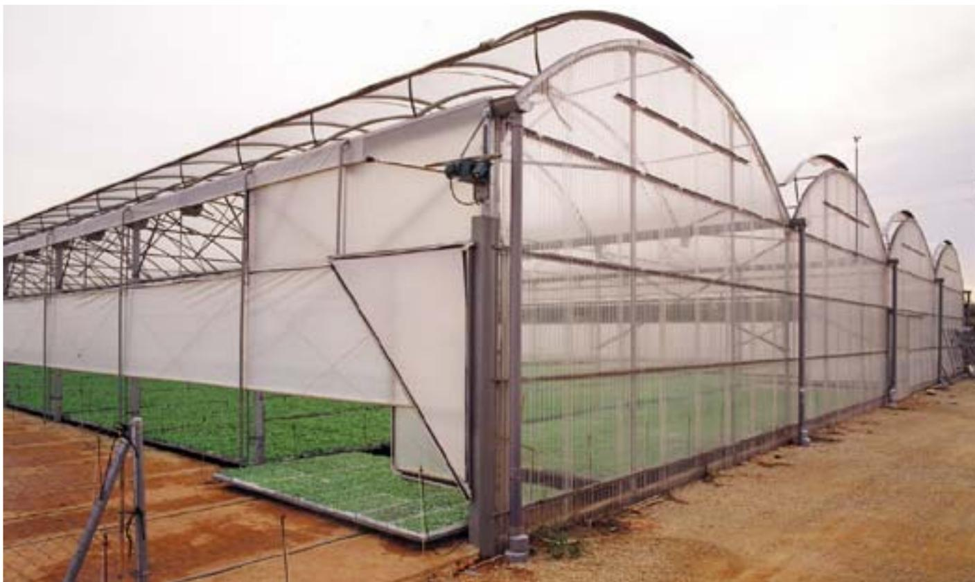
**Invernadero modelo de 8 m con una ventilación cenital y dos ventilaciones enrollables. Las bandejas sobre raíles permiten un rápido desplazamiento de gran cantidad de plantas dentro y fuera del invernadero.**
