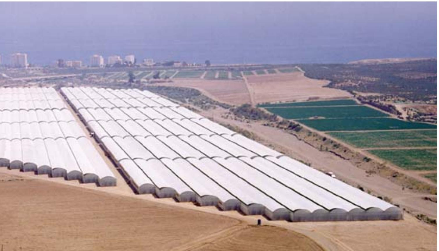
**Sobre estas líneas, un invernadero curvo, de 8 m de anchura, con ventilaciones cenitales en naves alternas, y laterales enrollables. A la derecha, invernadero en Ojiva de 9,60 m de anchura, con doble ventilación cenital y doble pantalla interior. (Fotos Inverca)**
