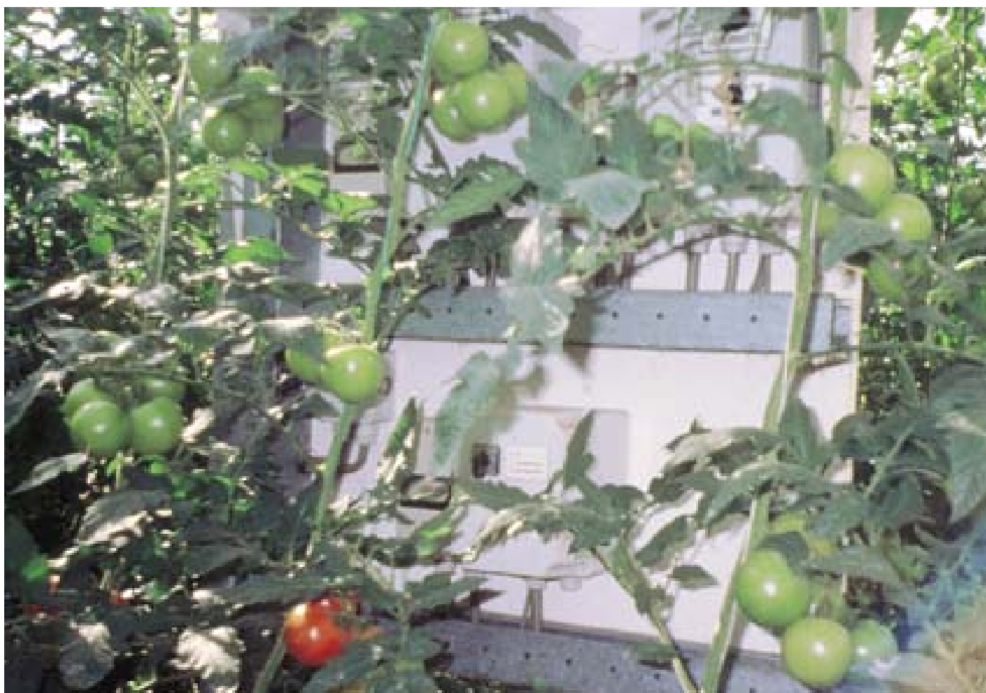
Cuadro eléctrico, conectado a un ordenador, utilizado en el control de un invernadero holandés.
